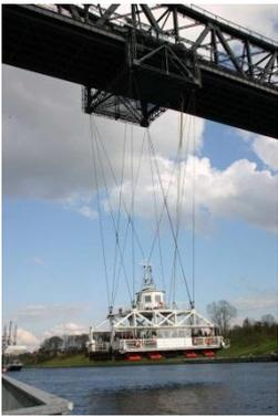
In Rendsburg steht eine 42m hohe Eisenbahn-Stahlbrücke mit einer an Stahlseilen hängenden Schwebefähre daran. Diese interessante Konstruktion ist beinahe 100 Jahre alt und funktioniert immer noch einwandfrei. Vier Autos und etliche Fussgänger finden darauf Platz, die Fähre ist gratis, so fuhren wir hin und zurück.
